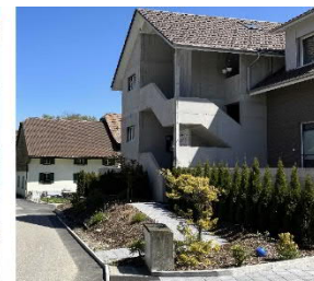
Treppenhausanbau, grosse Lukarnen, Böschungen
