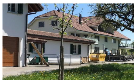
Nebenbauten angebaut mit flachem Satteldach, grosse Lukarnen, auskragende Balkone, Böschungen
