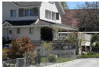
Kleine Einfamilienhäuser mit Garagenanbau (GGF ca. 100 m 2 )
